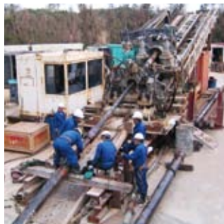
南大東島における掘削パイプの連結作業
