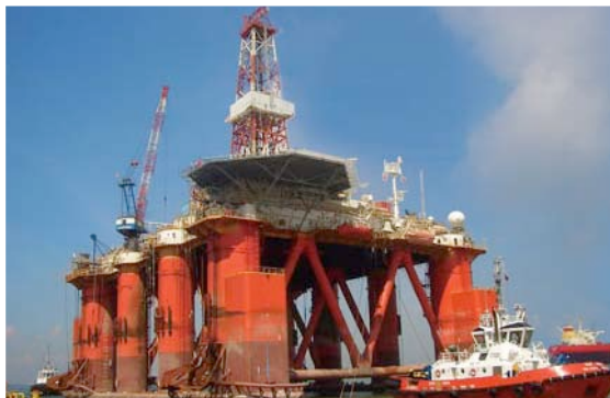
保守・整備工事後、シンガポールの造船所を離岸するHAKURYU-5
