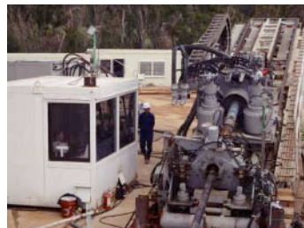
掘進中の水平孔掘削機
