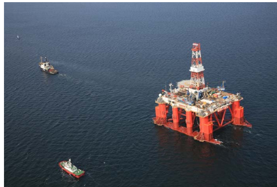
Deep Dish工事後、ベトナム沖へ曳航中の「HAKURYU-5」
